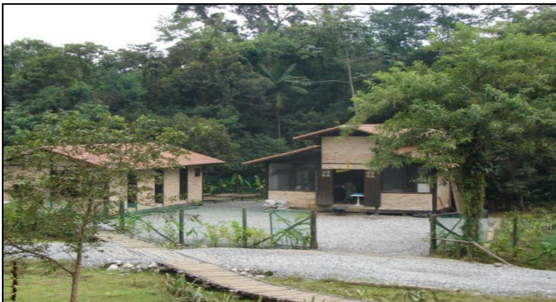
Foto 1: Estrutura do centro de manejo. Fonte: Gaia Consultoria e Gestão Ambiental.
