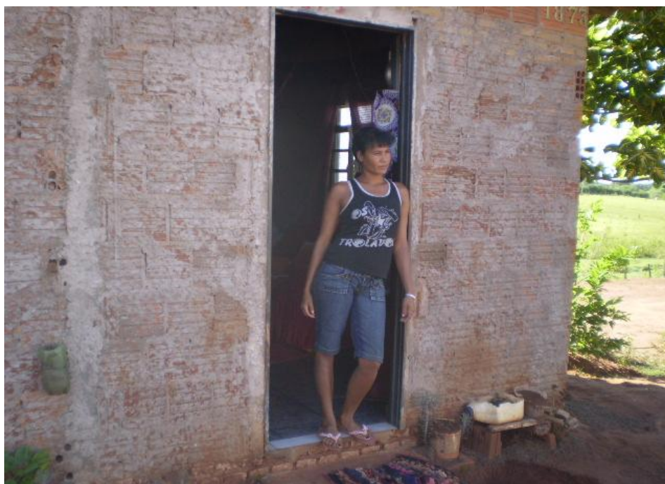
Figura 24 - Foto da casa de Solange, rua Amazônia, n. 1873, jardim Nossa Senhora Aparecida.
