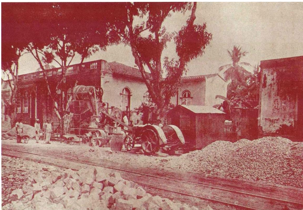
Imagem: Britadores e calceteiros empregados da prefeitura municipal de Belém, prestando o serviço de calçamento da Avenida Nazaré. 1930. Fonte: BELÉM. Relatório apresentado ao Conselho Municipal de pelo intendente municipal senador Antonio de Almeida Faciola. Pará, Belém, 1930
