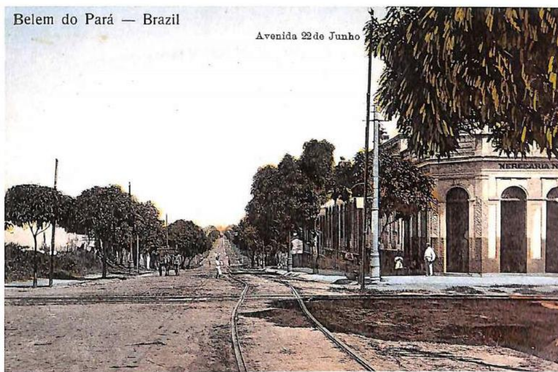
Imagem: Av. 22 de Junho, no cruzamento com a Avenida Gentil Bittencourt, em direção a Cremação. No detalhe à esquerda, percebe-se a fachada com a indicação da existência de uma mercearia, em uma rua de chão batido onde destacava-se os trilhos do bonde. Fonte: Belém da Saudade: a memória de Belém do Início do século em Cartões-postais. 2ª ed. Ver. Aum. Belém: Secult, 1998. p.109.
