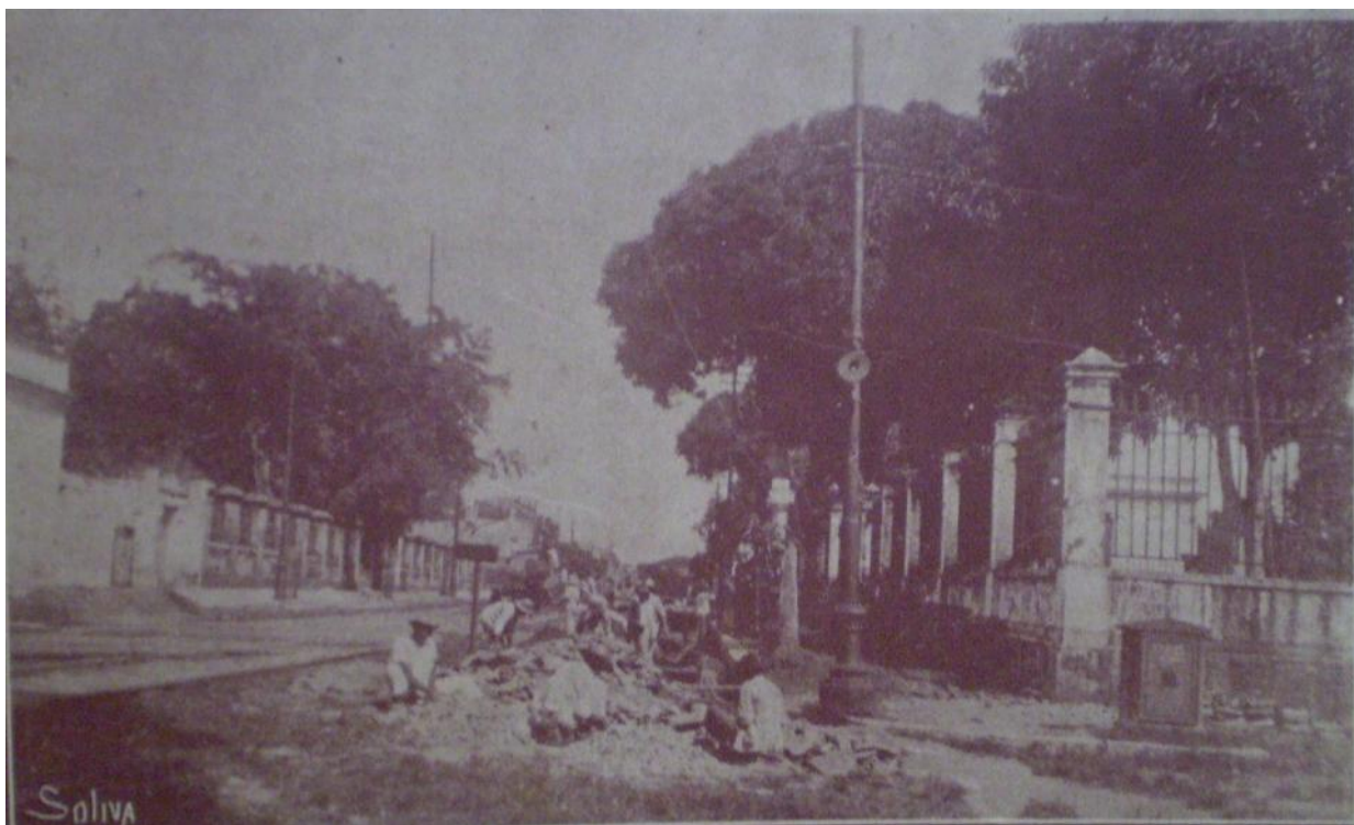
Imagem: Remodelação das sarjetas, como trabalho preliminar para o calçamento de macadame betuminoso.
