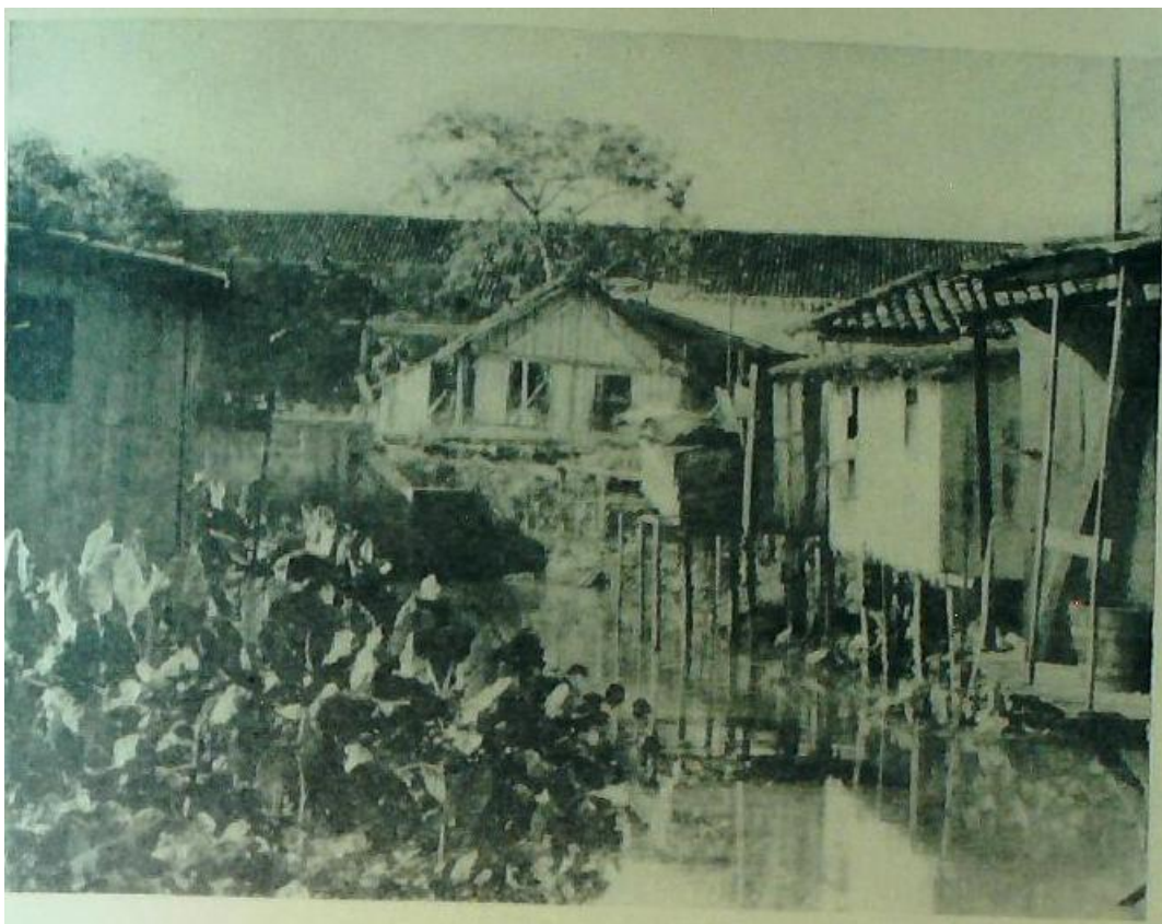
Imagem: Trecho junto à Avenida Marechal Hermes, no bairro do Reduto, próximo as obras de canalização do Igarapé das Almas; as quais geraram ao mesmo tempo maiores condições de urbanização em seu eixo de passagem e o empobrecimento dos outros territórios circunvizinhos. Data: em torno de 1948. Fonte: PENTEADO, Antonio Rocha. BELÉM – Estudo de Geografia Urbana . Belém: UFPA, 1968. Coleção Amazônica. 2 volume. pp. 288-289.
