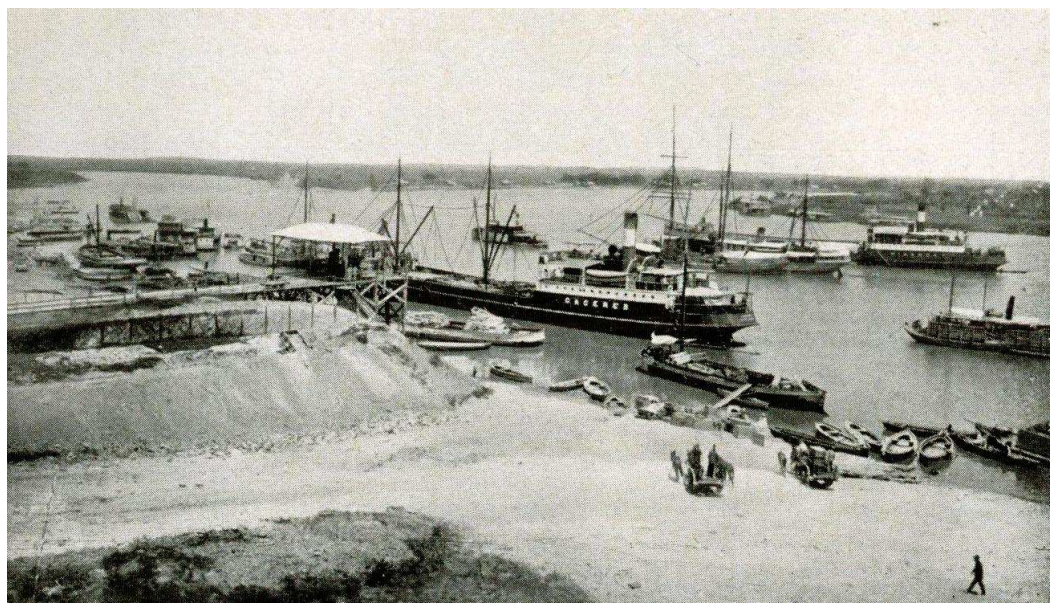
Ilustração 16 - Vista do Porto Geral de Corumbá-MT, 1914.
