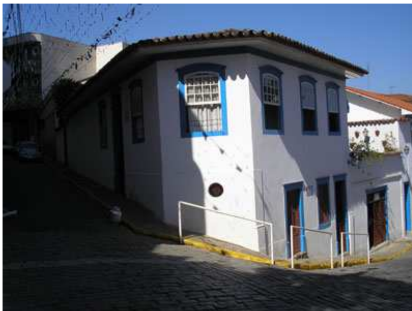
Ilustração 51 - Atual fachada da casa de frei Galvão.
