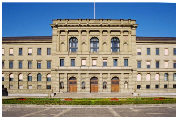
Figura 1: Edifício central da Escola Politécnica de Zurique, onde Antonio Francisco de Paula Souza estudou.
