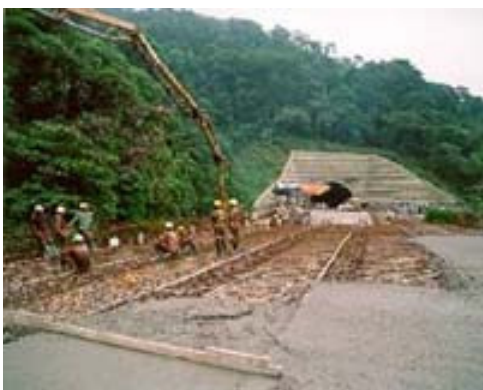
Figura 2: Detalhe da construção
