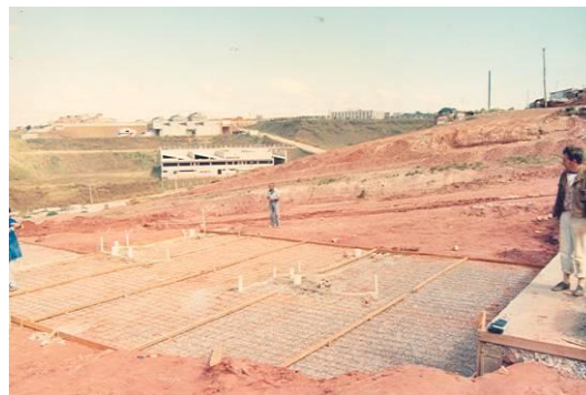
Figura 09 - ACCD: Construção de 280 Unidades Habitacionais
