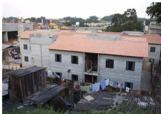
Figura 14 - NH Yamberê II- Unidades Sobrepostas em Construção
