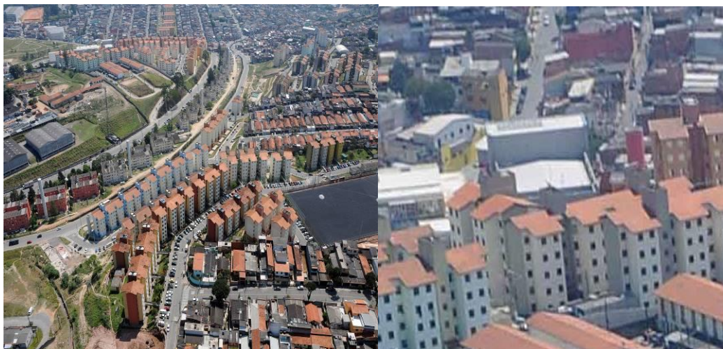
Figura 17- Conjunto Habitacional Jardim Esmeralda
