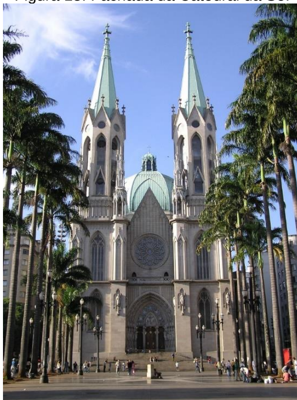
Figura 13: Fachada da Catedral da Sé.
