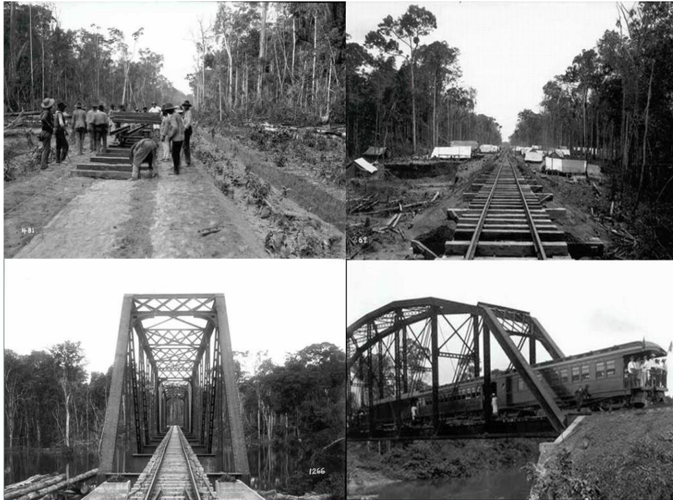
Foto 1: Trechos da EFMM em construção
