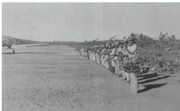
Figura 25: Uma das fases da construção do campo para pouso em Xavantina. Ano de 1944
