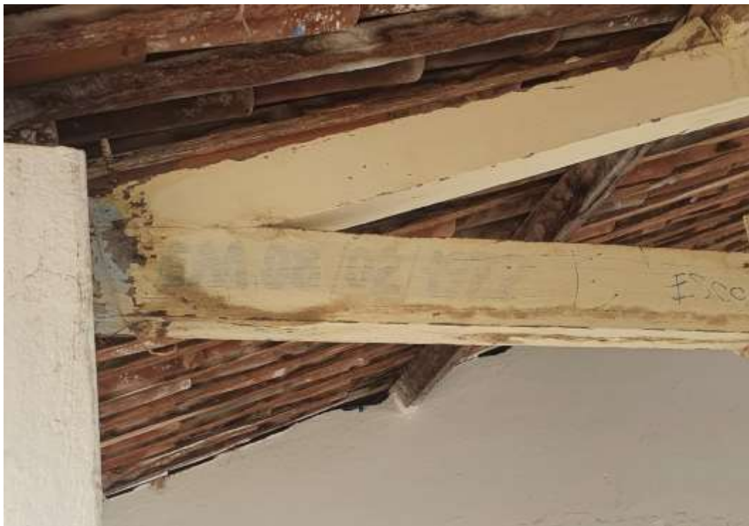
Imagem 6 - Viga com o registro da fundação: “08/02/1977”
