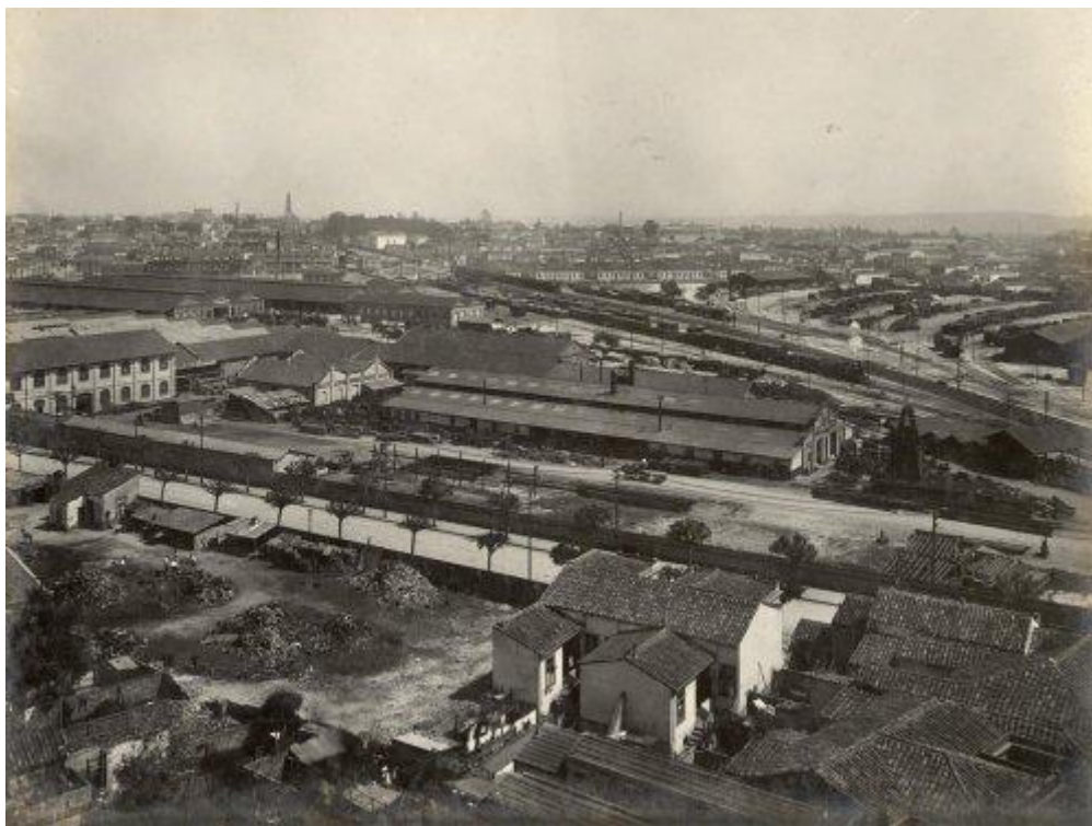
Figura 21: Complexo de Armazéns da São Paulo Railway. Disponível em: < http://www.estacoesferroviarias.com.br/p/pari.htm > Acesso em: 23 janeiro 2020
