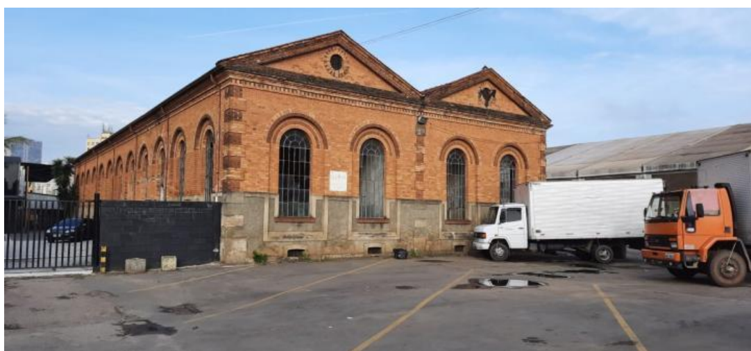
Figura 24: Parte da lateral e dos fundos de um dos armazéns. Foto do autor. 25 janeiro 2021.
