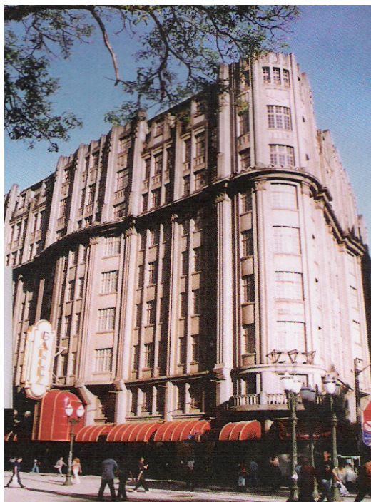
O primeiro “arranha-céu” (de 1936) só foi ultrapassado em altura nos anos 60.
