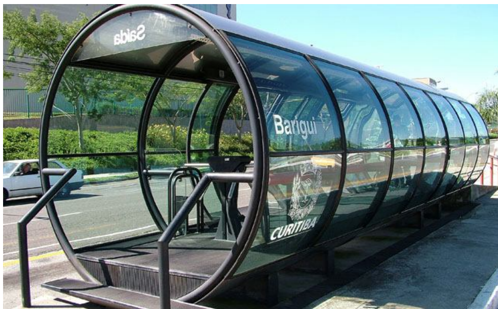
Figura 19: Estação tubo instalada próximo aos corredores de ônibus em Curitiba em que estão conectados à prefeitura de Curitiba por meio das TIC's.
