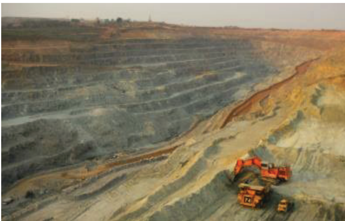
Foto 44 – Imagem da exploração do minério de Ferro na Serra do Carajás-PA
