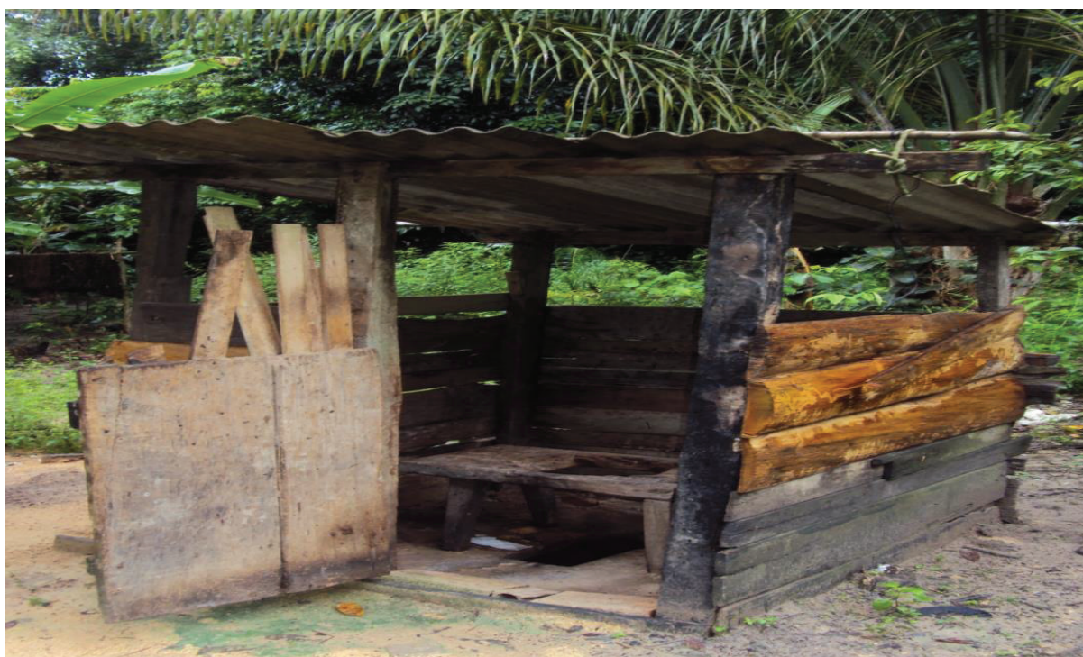
Foto 38 – imagem de sanitário usado por moradores de comunidade - Juruti-PA
